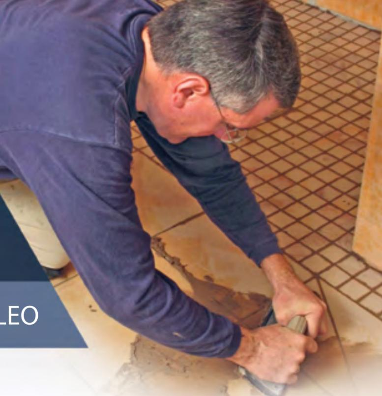
Una vez que el mortero ha adquirido cierta dureza, pase una esponja abrasiva para uniformar el acabado de las juntas. Luego, utilice una esponja húmeda bien escurrida para remover el material de la superficie. La limpieza final de la capa de polvo de IMPERCRETE® GROUT CON ARENA de la superficie se puede llevar a cabo con una tela limpia y seca. Espere 48 horas para tránsito liviano. Proteja al IMPERCRETE® GROUT CON ARENA de la lluvia por un mínimo de 12 horas.
