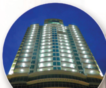
TORRE PASEO COLON
